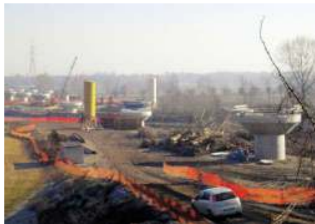
Corrono i lavori per la realizzazione della Brebemi
